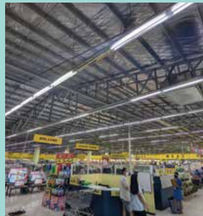
スーパーマーケット内部
